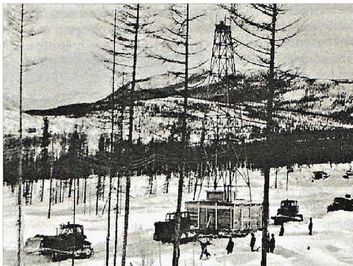
ХОЛОДНИНСКОЕ МЕСТОРОЖДЕНИЕ. ПЕРЕМЕЩЕНИЕ БУРОВОЙ ВЫШКИ НА НОВУЮ ТОЧКУ
