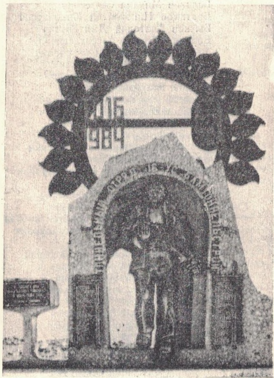
Памятный знак в честь сбойки тоннеля №3.
