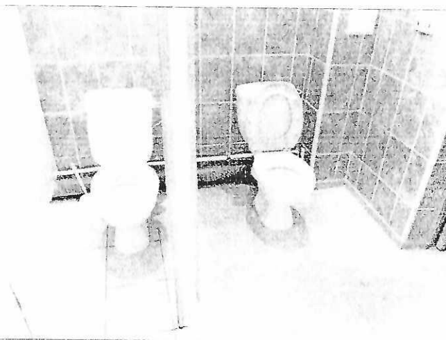
Фото №28 - Санитарно-гигиеническое помещение (кабина)
