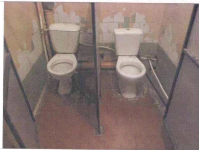
Фото №32 – Санитарно-гигиеническое помещение (туалетная кабина)
