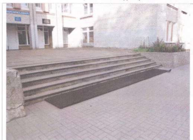
Фото №4 – Наружная лестница главного входа
