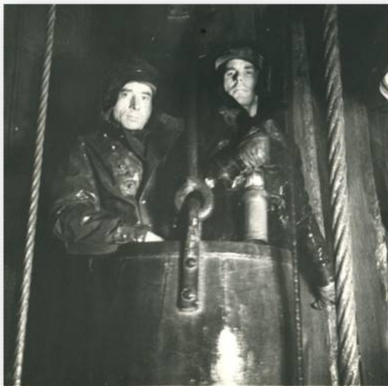
Бригадир проходчиков А.Г. Малыгин спускается в шахту
