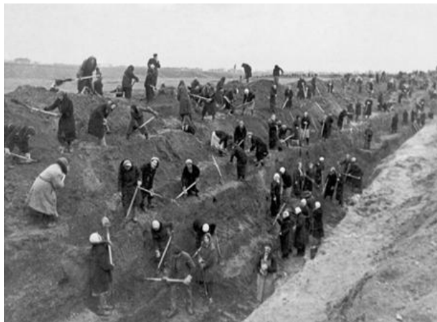
строительство Московской зоны обороны силами народного ополчения
