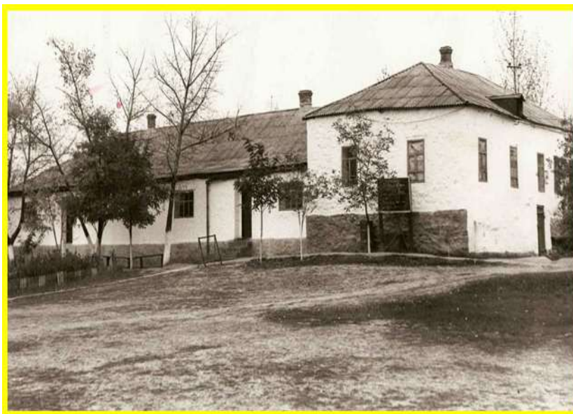
Здание старой школы
