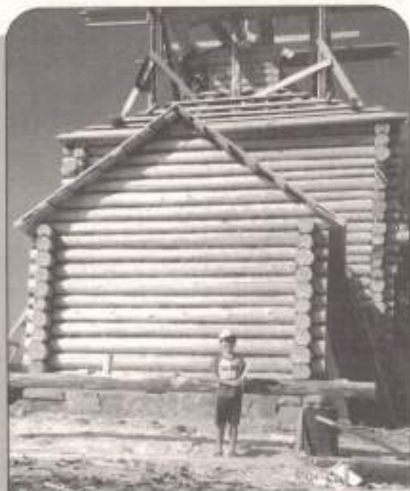
Строится деревянная церковь...
