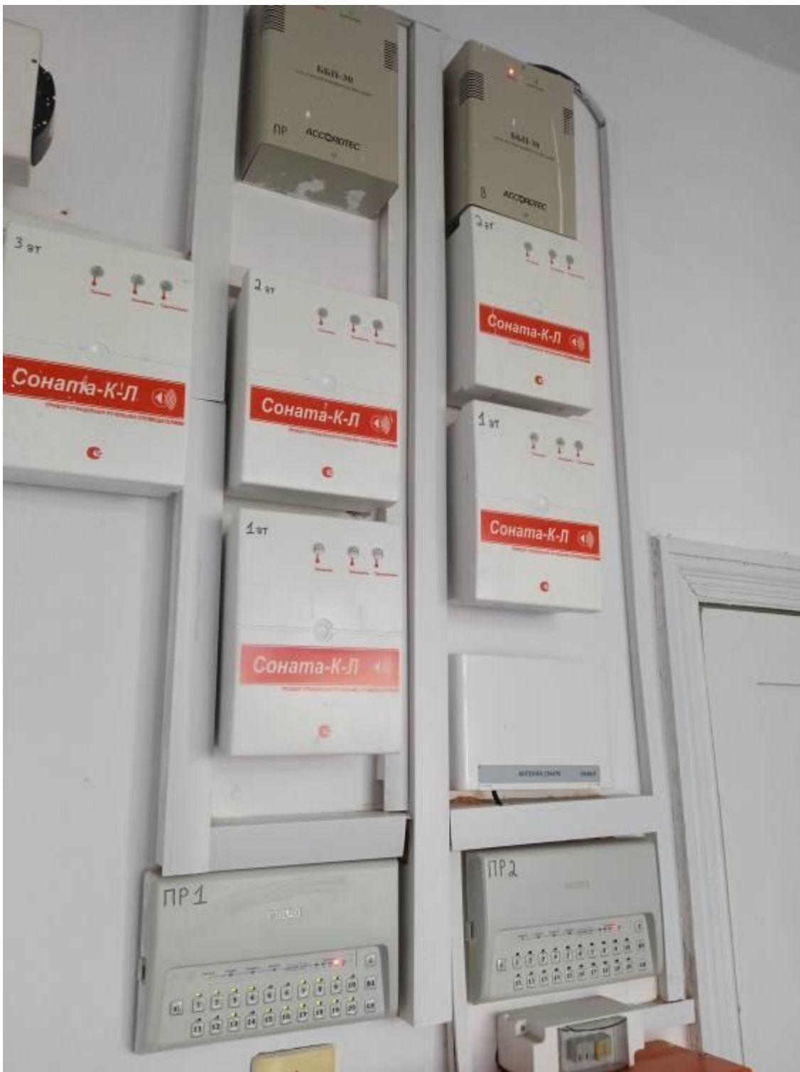
Фото 22. Пожарная сигнализация
