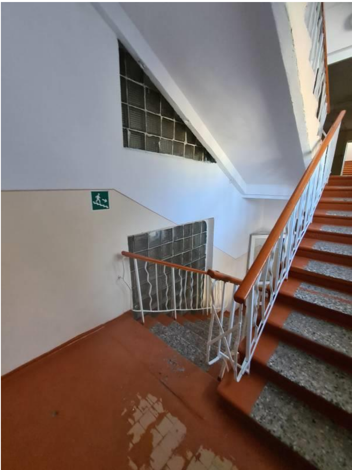
Фото 11 Лестница (внутри здания)
