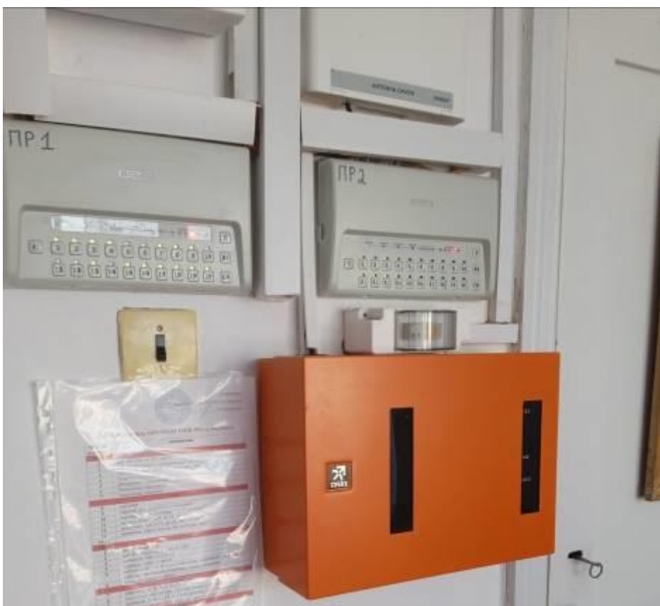
Фото 21. Пожарная сигнализация
