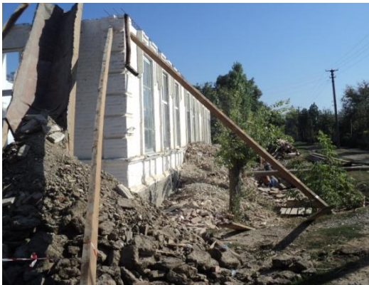
Ремонт детсада в 2010г.
