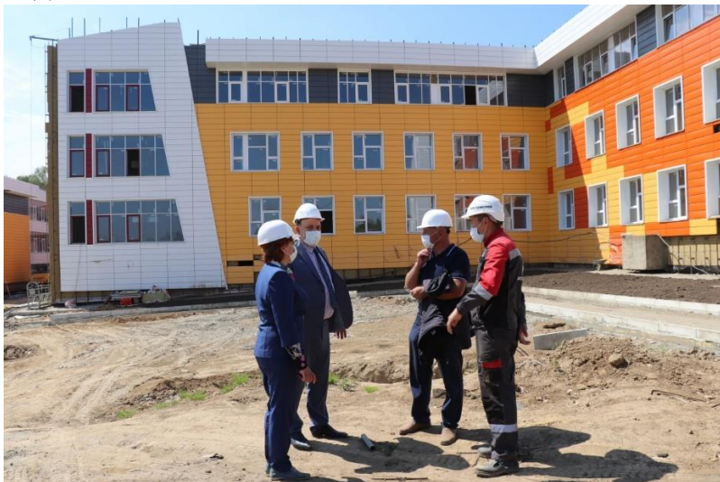
Строительство школы в ЖК "Юго-Западный". Фото: Пресс-служба администрации Иркутского района
