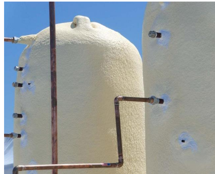
Утепление резервуаров
