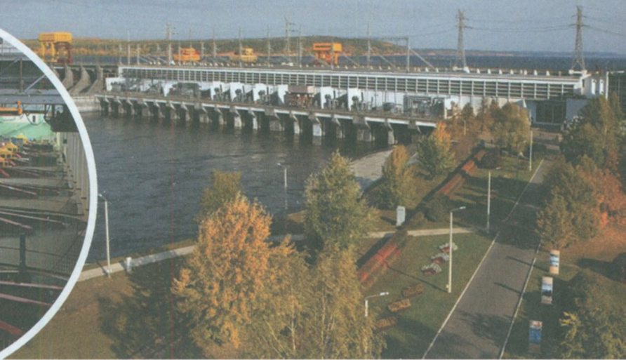
1. Машинный зал гидроэлектростанции. 2. Панорама Воткинской ГЭС
