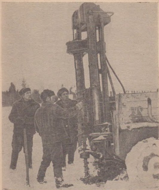
Буровая установка УРБ-1В на изыскании грунтов для проектирования объектов мелиорации.
