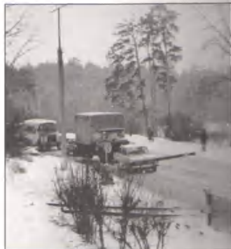
Автоматический шлагбаум на переезде
