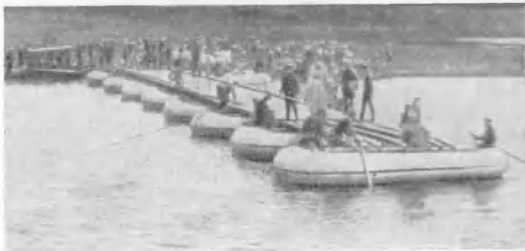
Саперы 57-й стрелковой дивизии в ходе маневров наводят мост на реке Исеть
