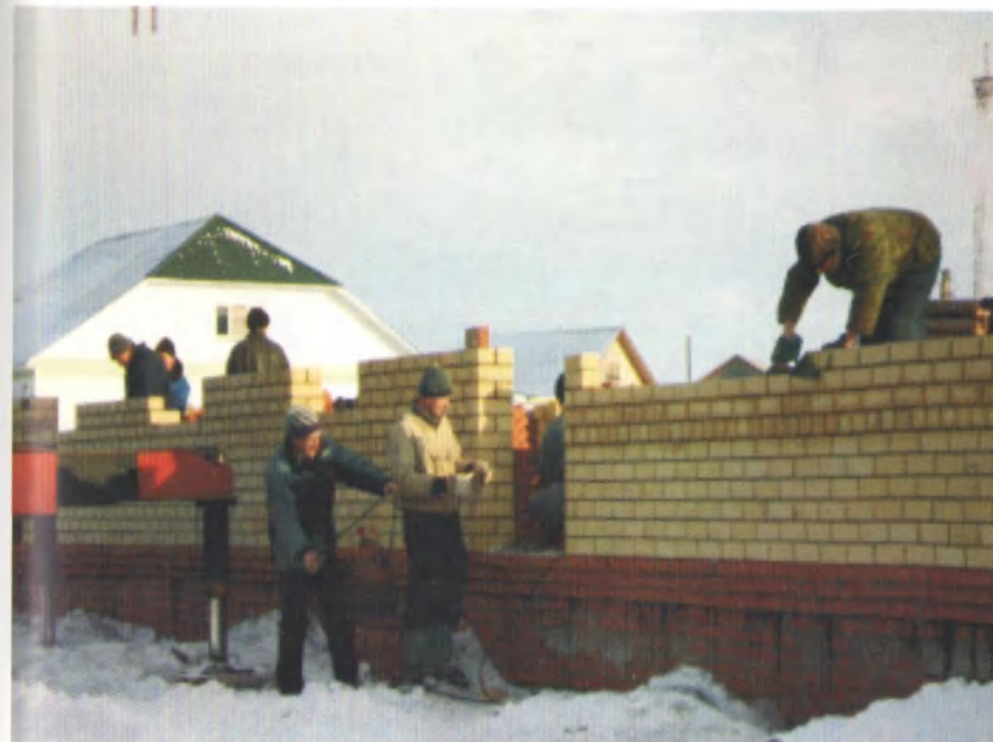
Идет строительство новой школы
