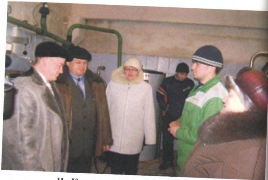
На Крыловской ферме установлено германское оборудование
