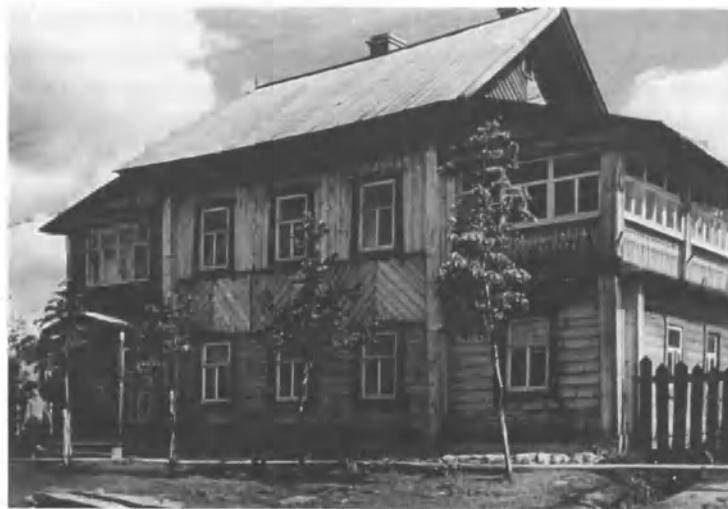
Здание Сельэлектро на ул. Коммунистической.
