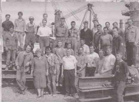
Бригада строителей Петра Копытова на сооружении одной из технологических установок "Пермнефтеоргсинтеза". В первом ряду в центре – генеральный директор треста Семен Вайсман. Фото 90-х годов.
