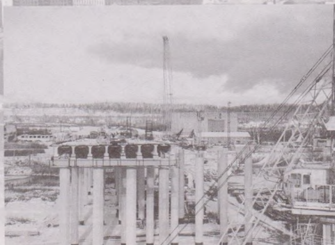
Строительство моста через Каму. Правобережный участок, 2004.
