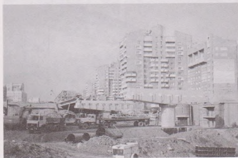
Строительство моста через реку Егошиху, 2003.
