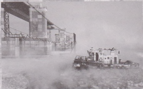
Сквозь ледяную шугу приходилось порой пробиваться строителям моста через Каму.
