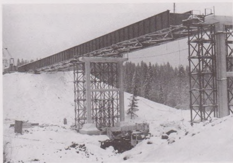
Надвижка пролетных строений моста через реку Мось. 2001.
