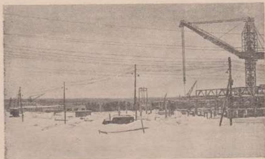
На строительстве комбината шелковых тканей в городе Чайковском.
