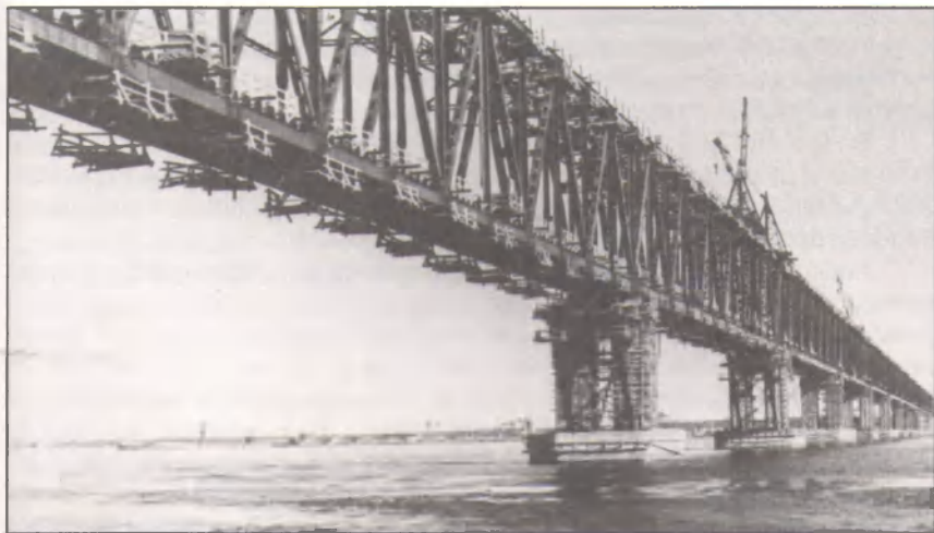
Строительство моста через Обь
