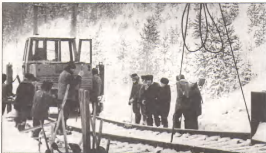
Путевые работы на перегоне
