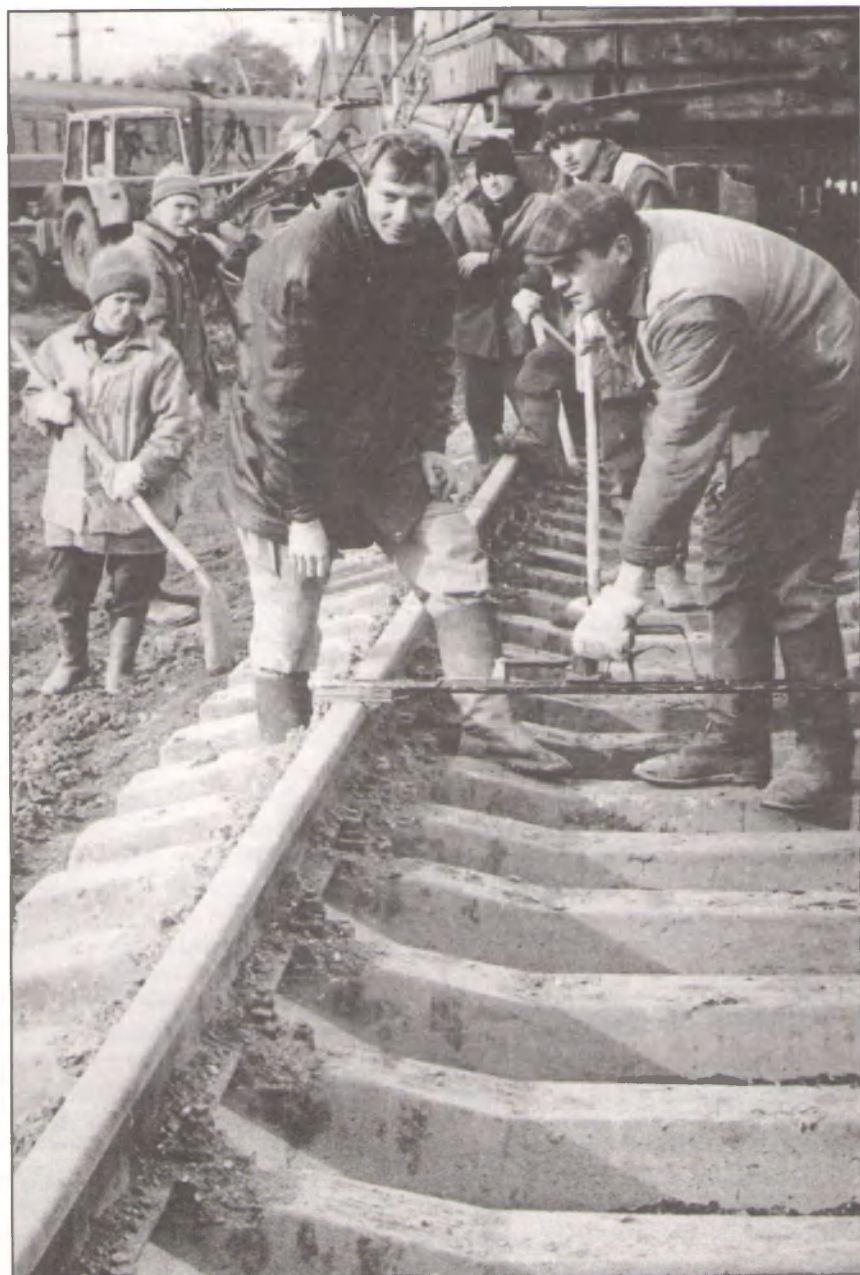
Промер установленного пути
