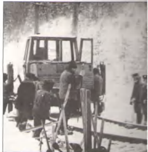
Путевые работы на перегоне
