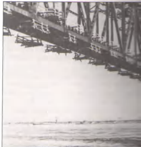
Строительство моста через Обь
