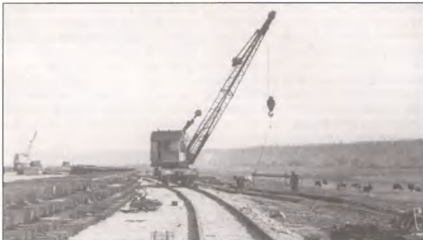
Строительство железной дороги Тюмень — Тобольск
