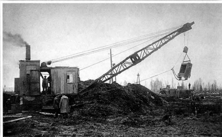
Строительство Камской ГЭС. Экскаватор. ГАПО. Фотофонд 63 (п) 556. Л. 16
