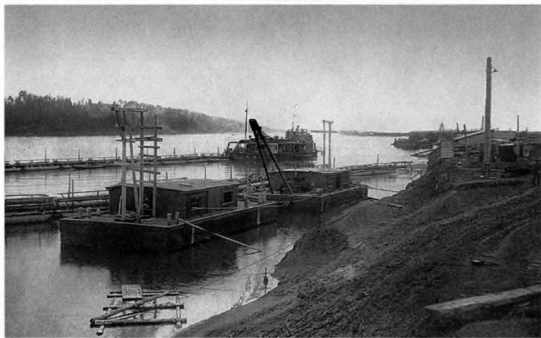
Строительство Камской ГЭС. Разгрузка барж. ГАПО. Фотофонд 63 (п) 556. Л. 3
