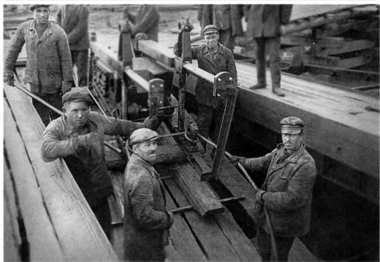
Такелажная бригада во время спуска паровой машины в корпус парохода на Пермской судостроительной верфи. 1936 г. ГАПО. Фотофонд 71 (п) 77
