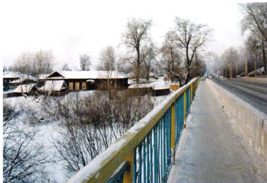
Софийский (синий) мост
