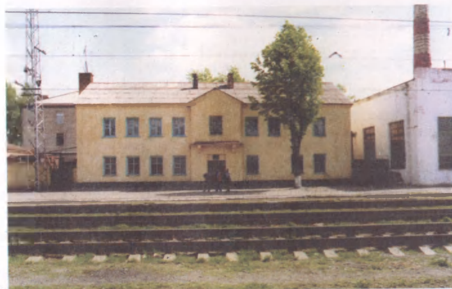
Здание ПТО ст. Верецагино.
