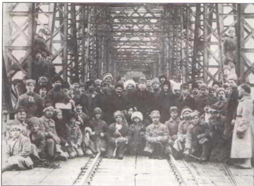
Участники восстановления Чусовского моста
