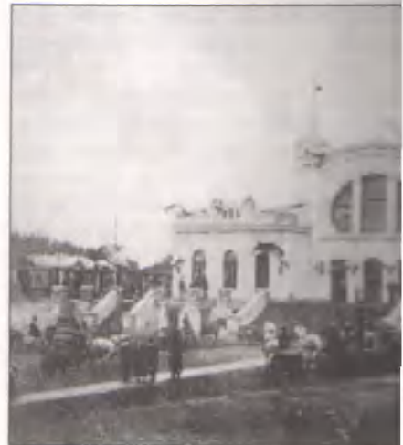
Вокзал станции Пермь-Займки
