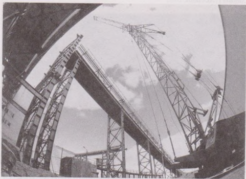
Строительная площадка Третьего Соликамского рудоуправления. 2001.
