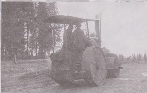
Дорожное строительство в районе рудника.
