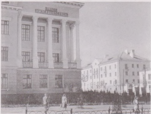
Кизел. Здание треста Кизелшахтстрой. 1952.
