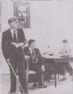
Начальник управления строительства Пермской ГРЭС Петр Пелих докладывает о ходе работ подготовительного периода.
