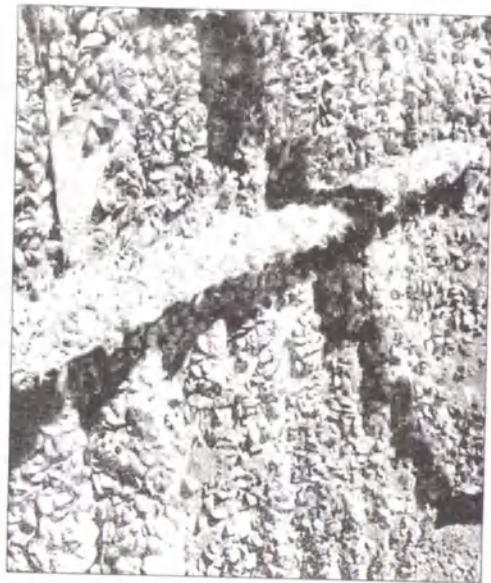
Скопление дрейссенид на решетках гидросооружений
