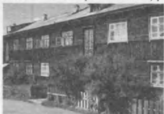
Дом, построенный в 1938 году для руководящего состава железной дороги на ст. Верещагино. Фото 2006 г.
