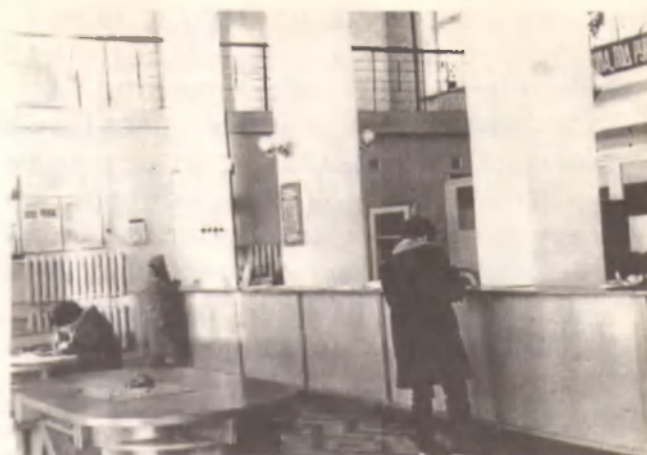
Новое здание узла связи.
