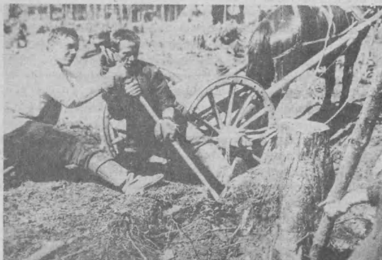
Грабари корчуют пни. Начало строительства Уралмашзавода. 1928 г.
