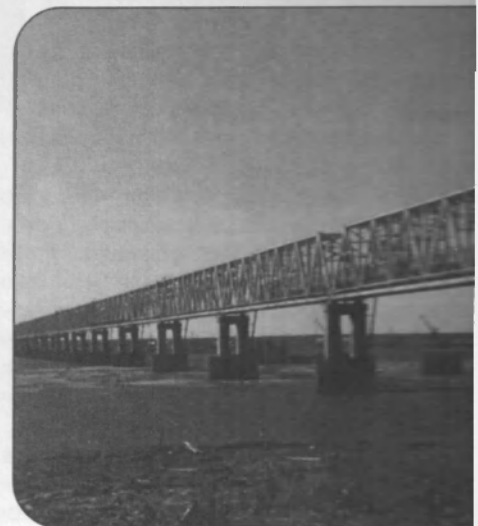
Мост через Обь
