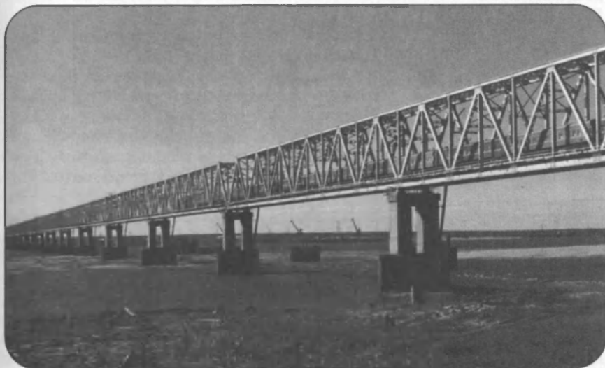
Мост через Обь
