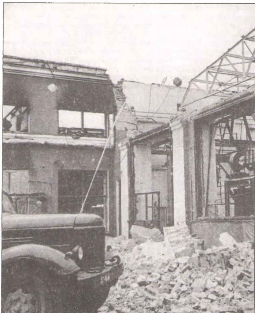
Цех вагонного депо Свердловск-сортировочный, разрушенный взрывом
