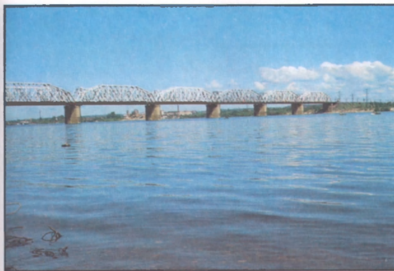
Железнодорожный мост через Каму
