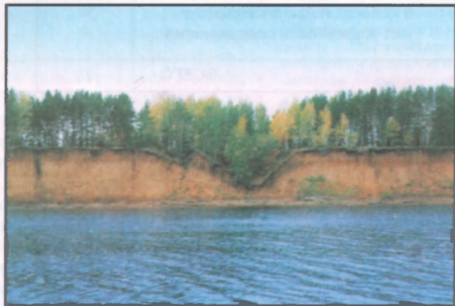
Разрушительная работа оползня. Оханский район
