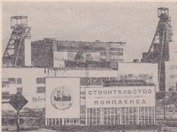
Новые корпуса Второго калийного комбината.
