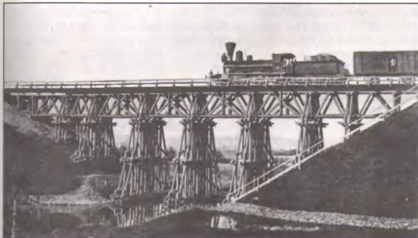
Мост через реку Вязовку
