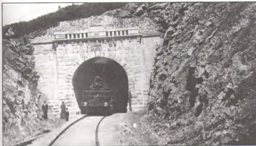
Тоннель на 22-й версте
