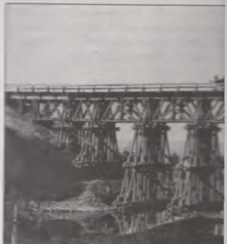
Мост через реку Вязовку
