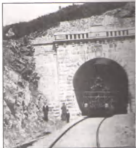
Тоннель на 22-й версте
