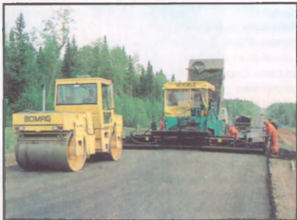
При реконструкции дорог используется самая современная дорожно-строительная техника
