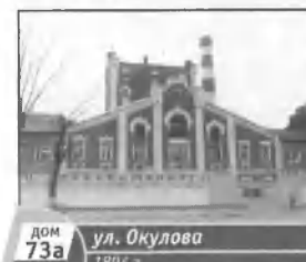
Завод спиртоочистительный. Сейчас здесь располагается хлебозавод.
