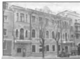
ДОМ 5 ул. Сибирская 1907 г.
