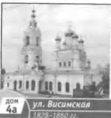
Церковь Святой троицы. Свято-Троице-Стефанов мужской монастырь. В 1936 г. здание церкви было переоборудовано под цех хлебозавода. В 1994 г. вновь появилась надпись «Свято-Троицкая церковь», а в 1995 г. родилась идея создания мужского монастыря на базе возрождающейся церкви.
