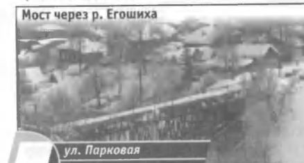
Мост через р. Егошиха ул. Парковая
