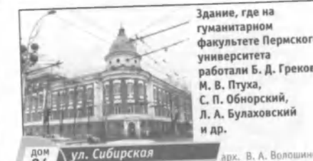
ДОМ 24 ул. Сибирская 1913 г.
