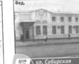
ДОМ 27 ул. Сибирская 1820 г.
