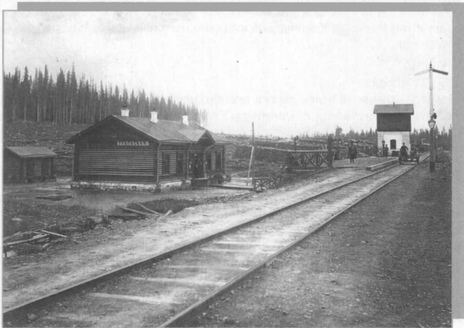
Станция Уральская. 1878 г.
