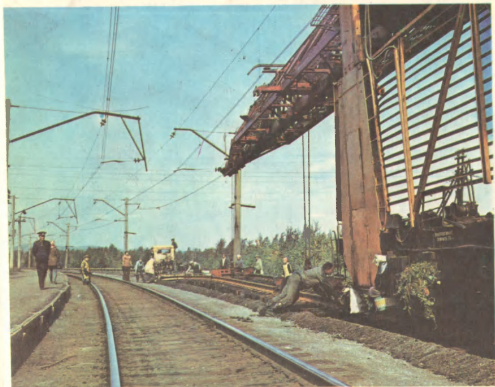
Восьмичасовое «окно». Капитальный ремонт пути у станции Шувакиш
