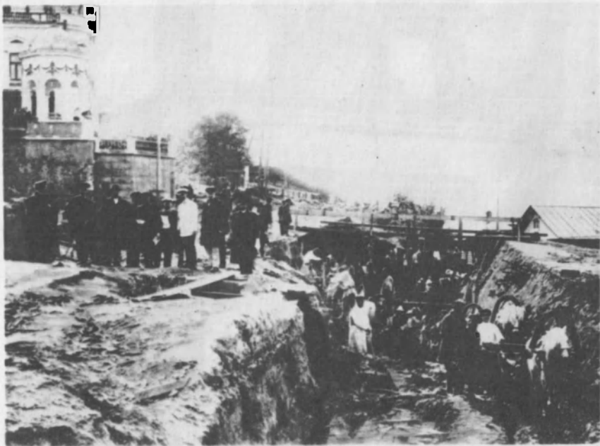
Строительство перегона Пермь — Займка
