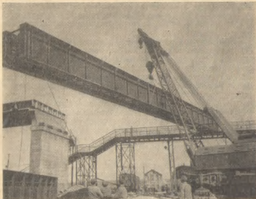
Строительство моста через железнодорожный переезд и реку Кизел.
