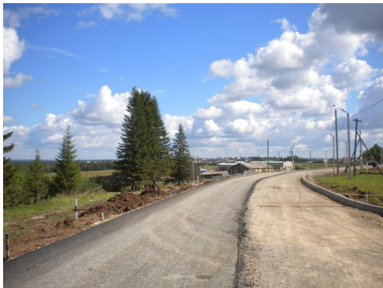
Окраина села Коса. Строится дорога (10.08.2015, фото – Марина Чжан , Пермь)
