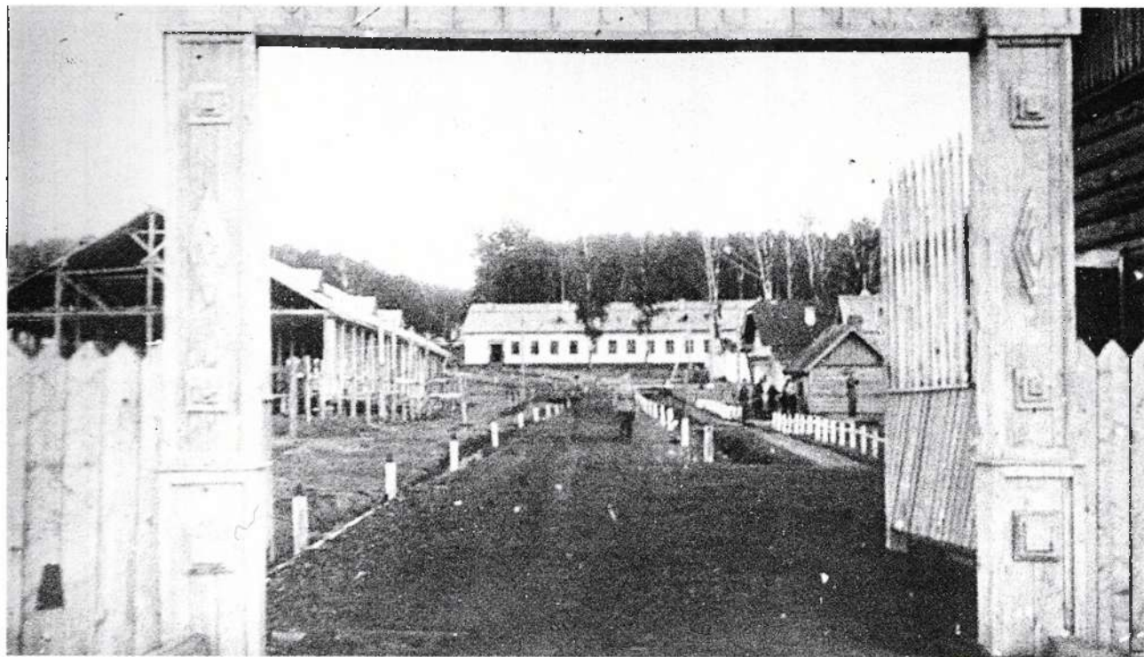
№ 58. Ворота, ведущие на территорию Киевского танкотехнического училища. г. Кунгур, Молотовская область. 1943 г. КГА. Ф. 477. Оп. 1. Д. 289. Л. 4.
