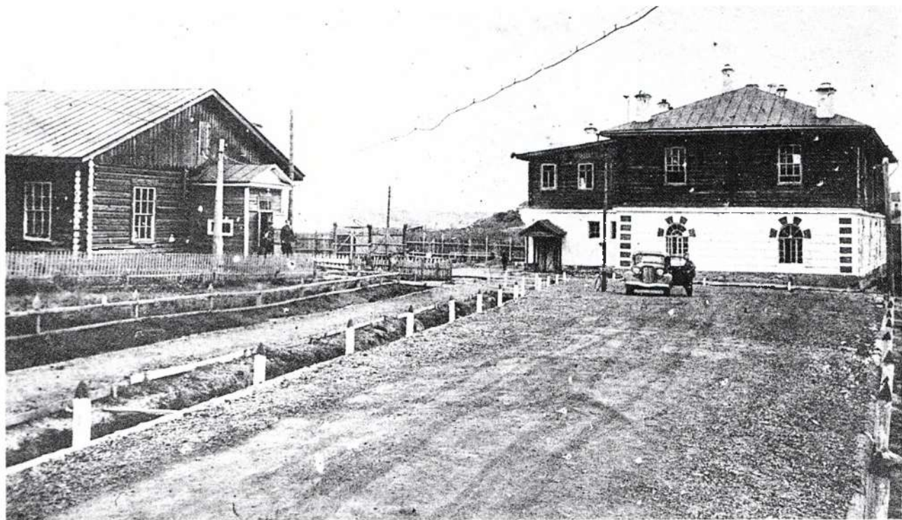
№ 59. Каменная мостовая на шлаковом основании на территории Киевского танкотехнического училища. Вид летом. г. Кунгур, Молотовская область. 1943 г. КГА. Ф. 477. Оп. 1. Д. 289. Л. 4об.
