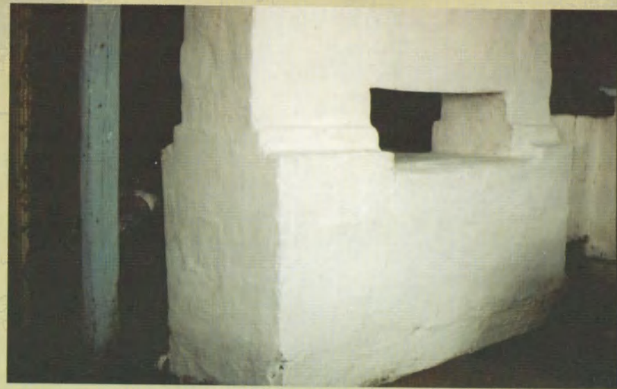
Камин (теплая стенка), выходящий в центральную комнату в доме семьи Ратке, д. Ивановка Чернушинского района, 2000
