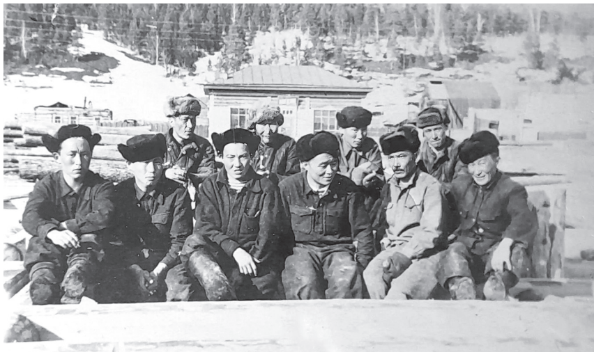
Бригада строителей возложила фундамент будущей школы
