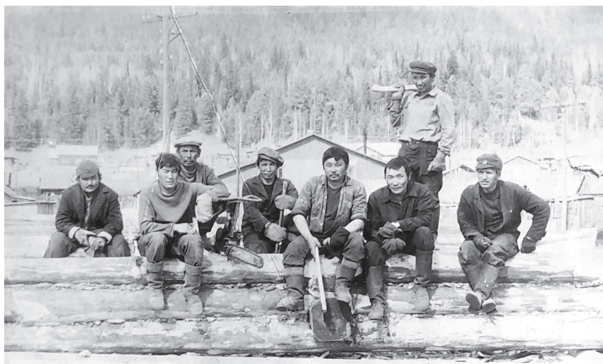
Бригада строителей села
