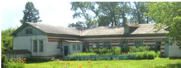
Здание, в котором расположена библиотека
