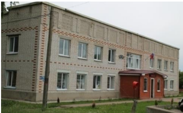
Здание администрации, в котором расположена библиотека
