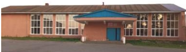
Здание СДК, где расположена библиотека
