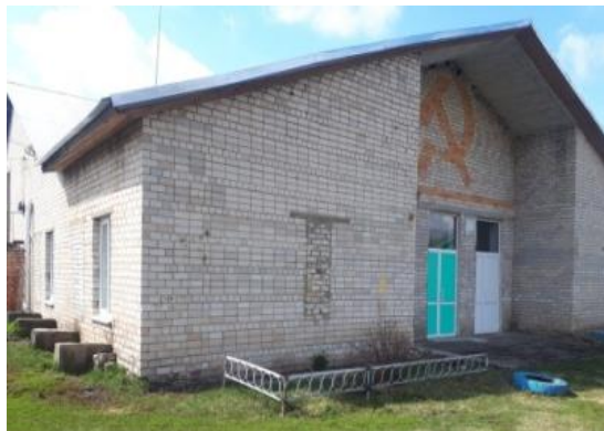
Здание СДК, где расположена библиотека
