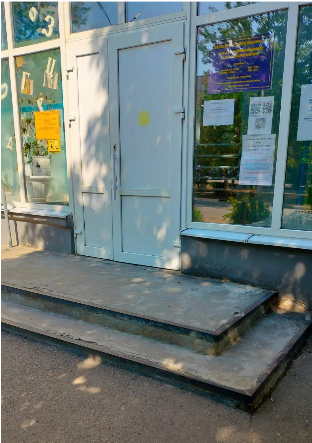
Фото 5. Входная площадка перед дверью
