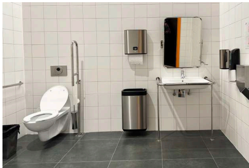
«Новая школа», г. Москва Санузел для МГН и гостей. Все элементы подвесные, что значительно упрощает уборку
