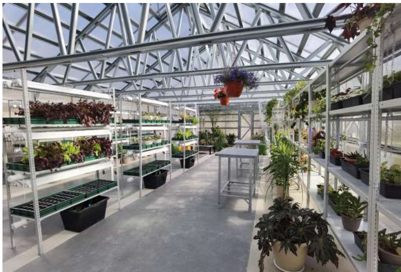
Мастерская агропромышленного профиля / теплица, Калужская общеобразовательная школа-интернат № 5 имени Ф.А. Рау для обучающихся с ограниченными возможностями здоровья, г. Калуга, Калужская область
