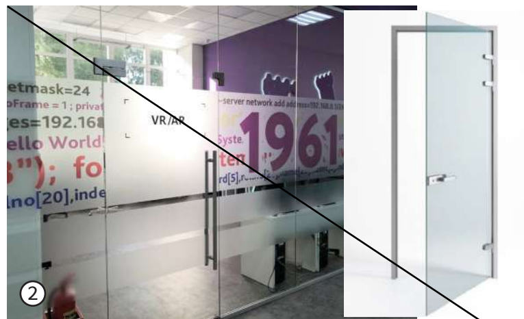
2. Стекланные двери без коробки требуют большего внимания при использовании и создают дополнительные риски
