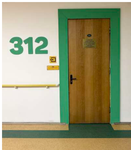
Контрастный линолеум вдоль стен помогает ориентироваться людям с нарушениями зрения и не мешает передвигаться другим пользователям
