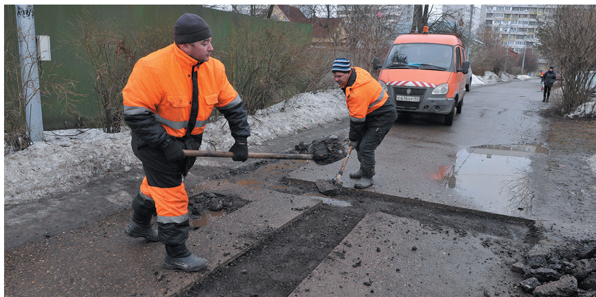
2-я Мичуринская: косметический ремонт идёт успешно
