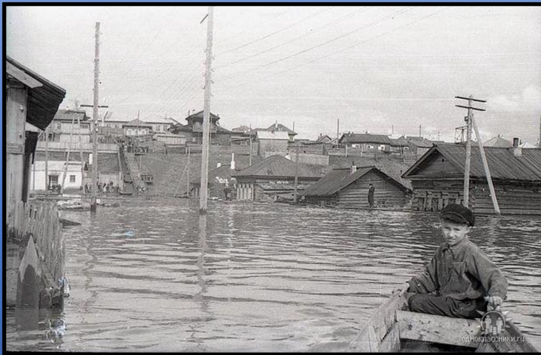
Вид лестницы в наводнение 1961 г.
