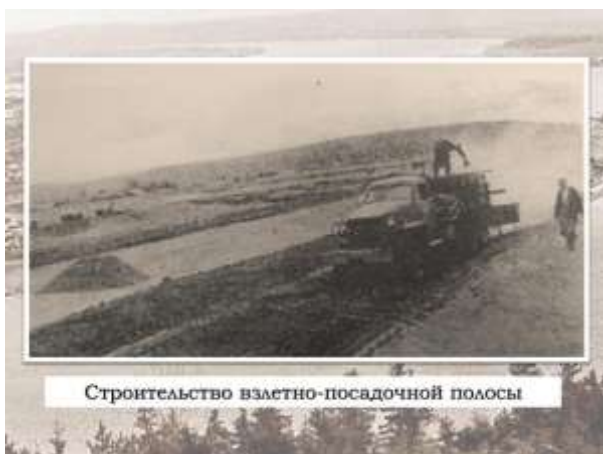
Рис.3. Строительство взлетно-посадочной полосы
