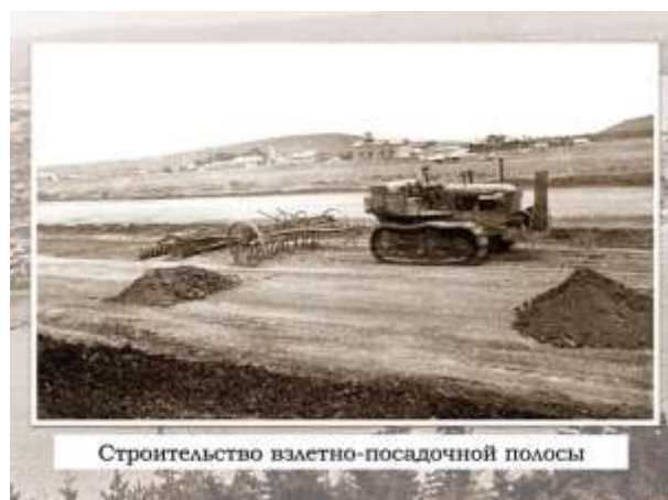
Рис.4. Строительство взлетно-посадочной полосы
